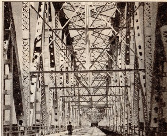
Puente metálico sobre el río Magdalena, con vía férrea, vehicular y peatonal. Foto Ferrocarriles Nacionales de Colombia
