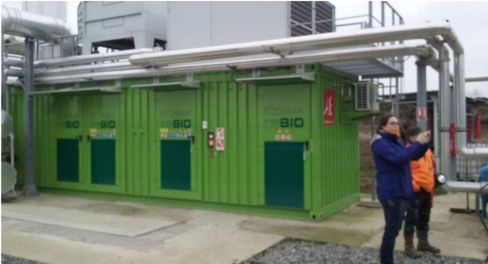
Foto 8. Con el gas producido en la planta de metanización se genera energía eléctrica en estas instalaciones.
